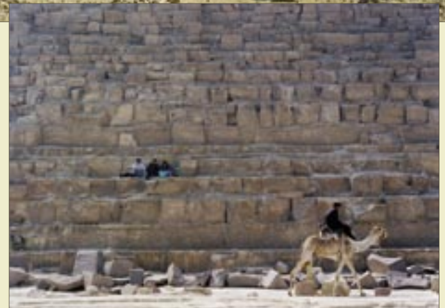
Piramides zijn opgebouwd uit blokken van kalksteen die in gewicht variëren van 3 tot 30 ton. De grote piramide van Gizeh is 140 meter hoog.
